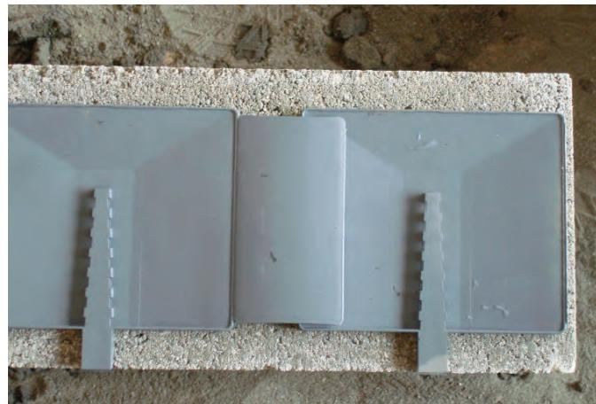
**El sistema vierteaguas completo para construcción con bloques de concreto de pilastra simple**
